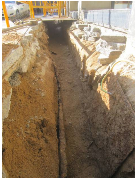
8. Cablejat elèctric davant la finca núm. 40.
