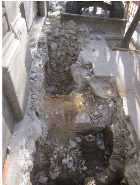
4. Demolició del paviment actual UE 1.
