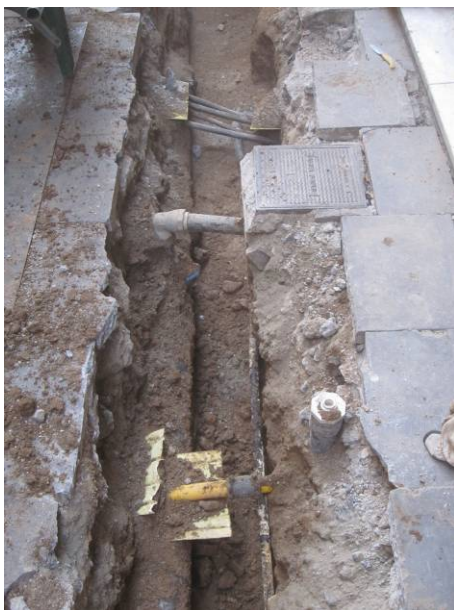
11. Serveis de llum, aigua i gas enfront de la finca núm. 36.
