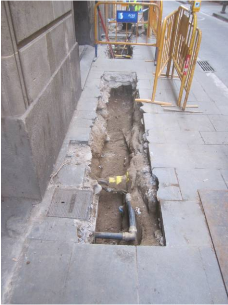
13. Escomesa d'aigua i llum enfront de la finca núm. 30-32.
