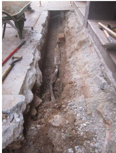
10. Cablejat elèctric entre les finques 36 i 38.
